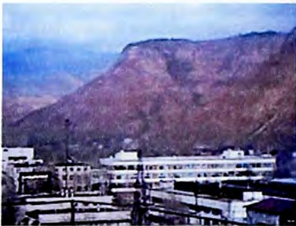
Майлуу-Суу электр-лампа заводу.
